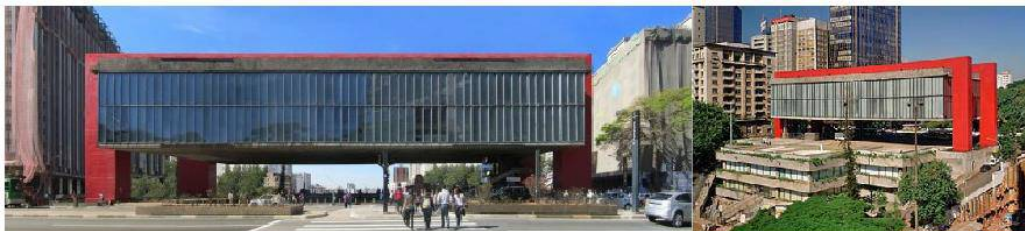
Figura 4: Pórticos sustentando a estrutura do edifício MASP.
