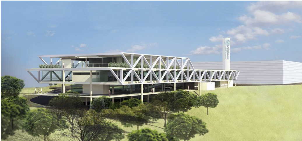
Figura 3: Treliças metálicas e painéis de vidro na fachada.
