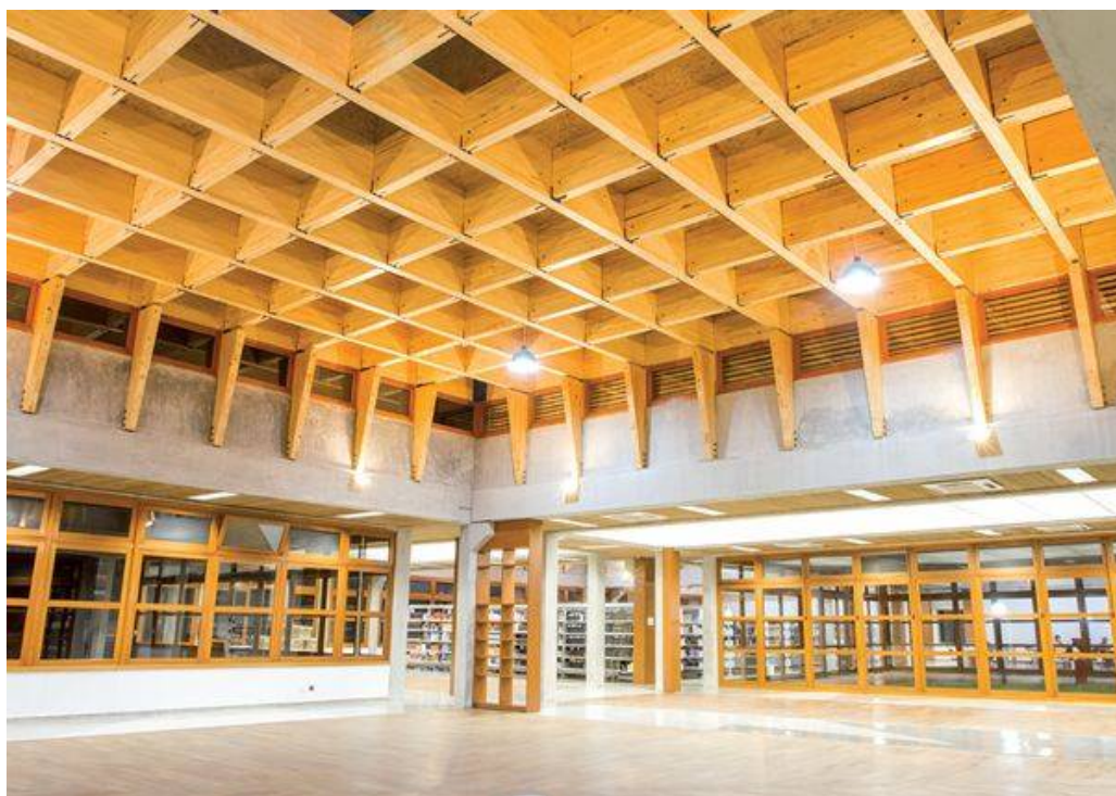
Figura 2: Grelha fabricada com pinus na Biblioteca Paulo Freire.
